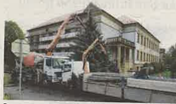
Betonování vstupního schodiště
