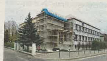
Zateplovací práce v plném proudu
